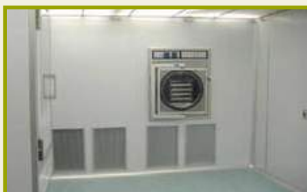
Sala dotada de fluxo laminar, classe ISO 5 100, onde o tecido musculoesquelético é processado
