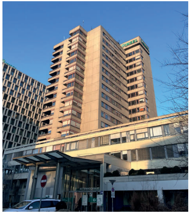
Prédio do Inselspital, na Suíça, local do estágio.
